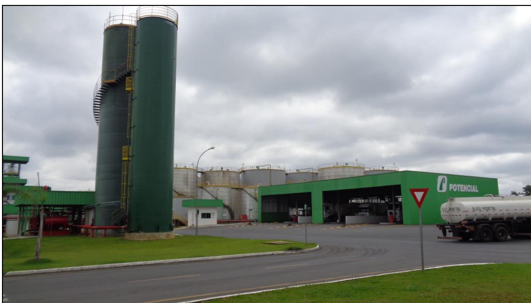
Foto 2: Vista da área de expedição de biodiesel da Potencial Biodiesel LTDA.
